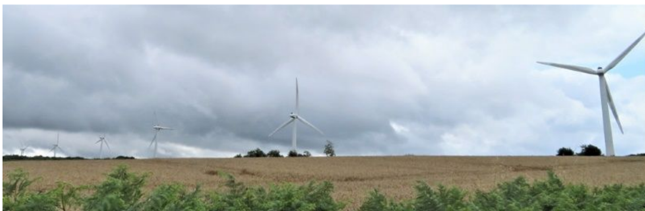
Figure 1 : éoliennes du parc actuel (photo Michèle Philippe)
